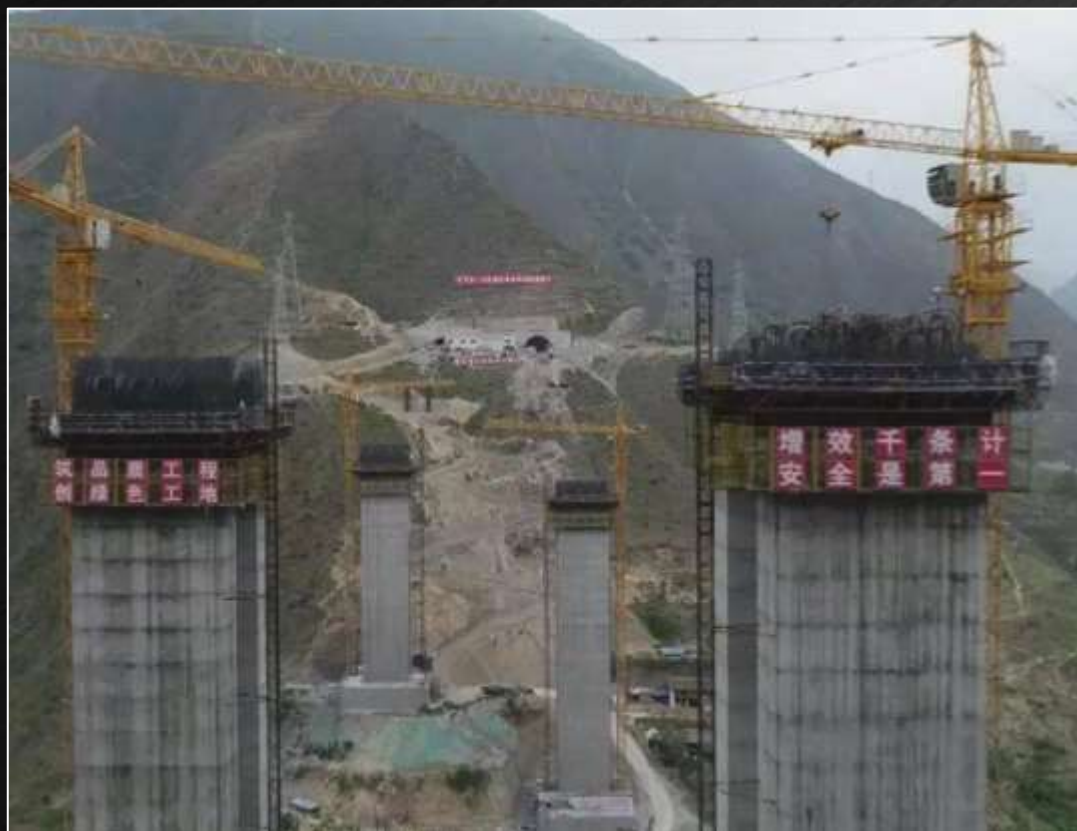
施工工艺复杂
