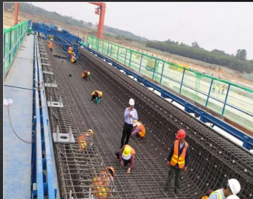
施工安全难保障
